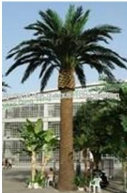
Figura 10 Camuflaje de torre de telefonía celular en Mailand Shandong China. [5]
