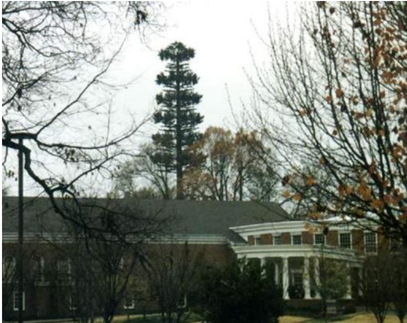
Figura 9 Camuflaje de torre de telefonía celular instalada en Tennessee, Estados Unidos. La estructura esta compartida con seis proveedores de telefonía celular. [3].
