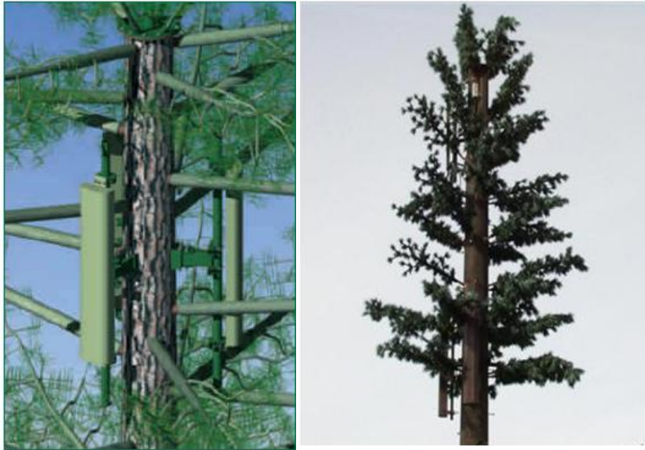
Figura 2 Montaje de equipos en torres estilo pino [2] [3].
