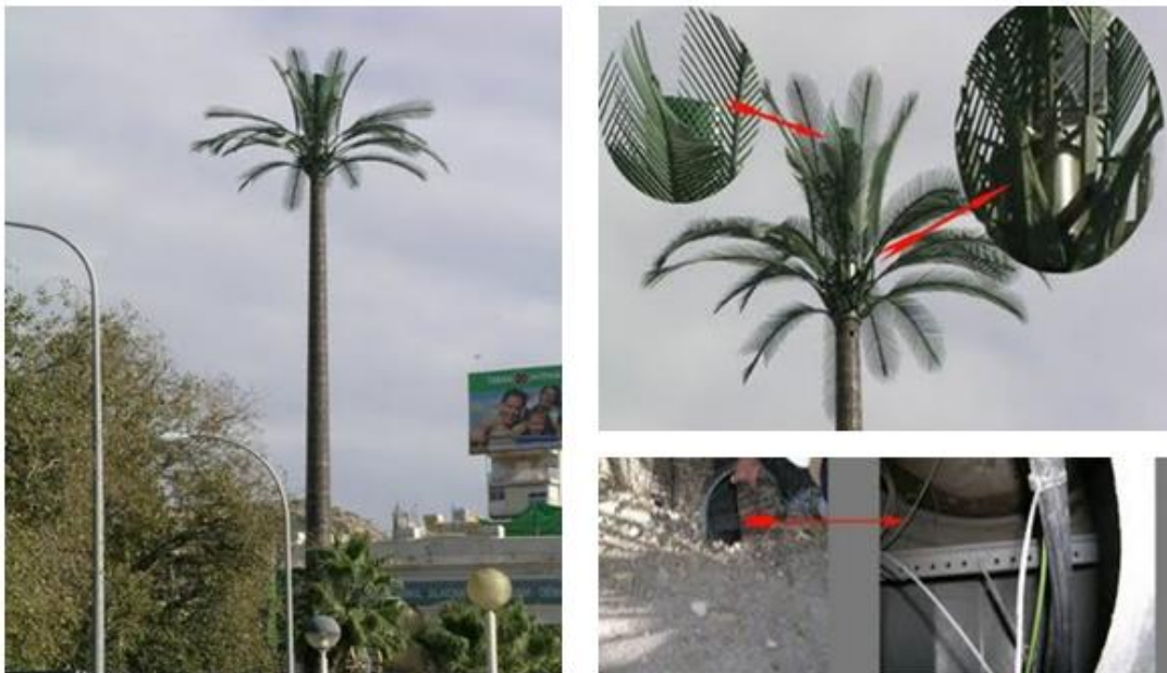
Figura 8 Camuflaje de torre de telefonía celular instalada en la Ciudad Alicante en España. [1]
